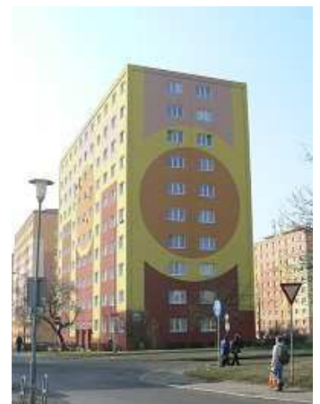
Barevné panelové domy v Mostě, ulice Hutnická (Kolářová, 10. 3. 2008)
